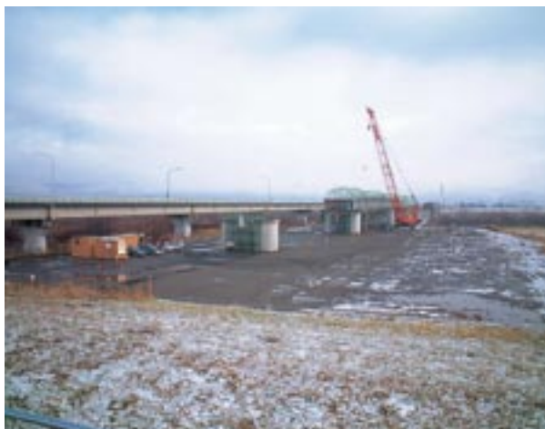
千代田大橋の新橋への架け替え工事
