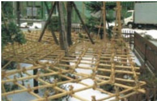
写真-4 タケ（真竹）とワラ縄で組まれた、積雪の沈降圧に対する水平な冬囲い
