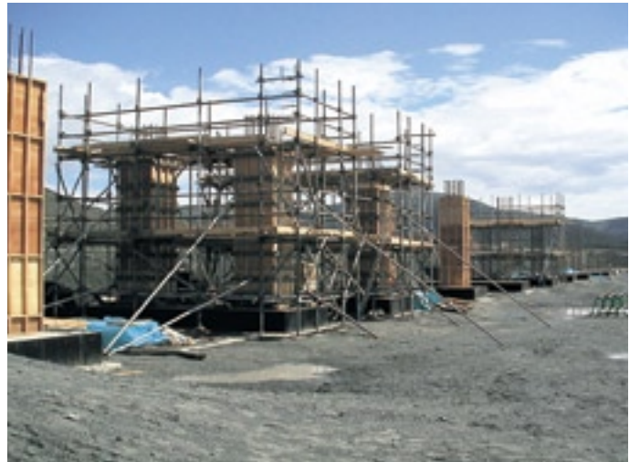
ワッコル施工「パイプラック基礎」
