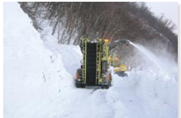
雪崩後の復旧作業
