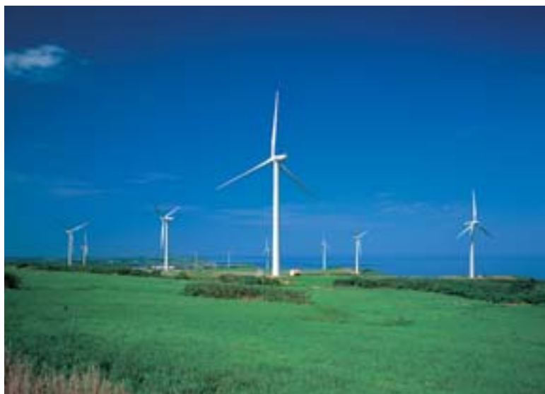
風力発電の風車（苫前町）
