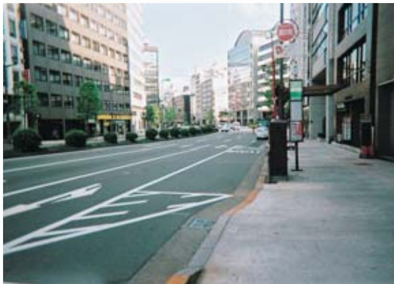
新宿通り～電線が埋設され、すっきりとした印象
