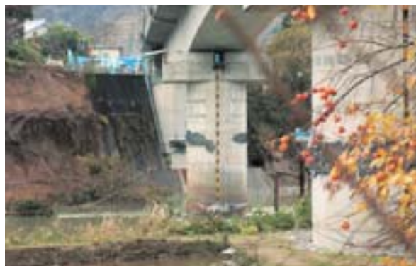
新幹線魚野川橋梁
