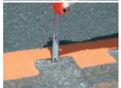
写真—1 ランブルストリップスの設置状況
