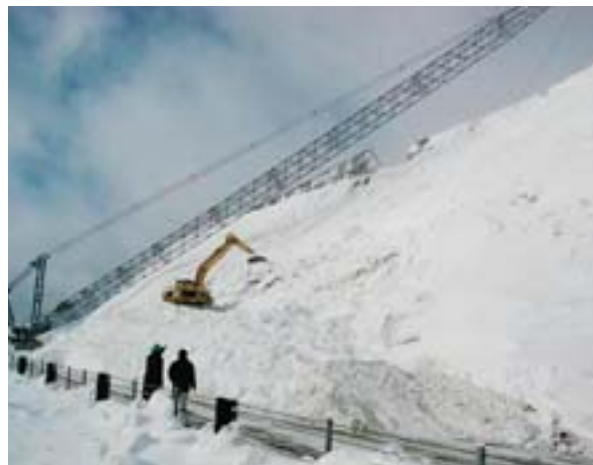
写真6 機械による斜面上の不安定な雪の除去作業 （一般国道243号美幌峠）
