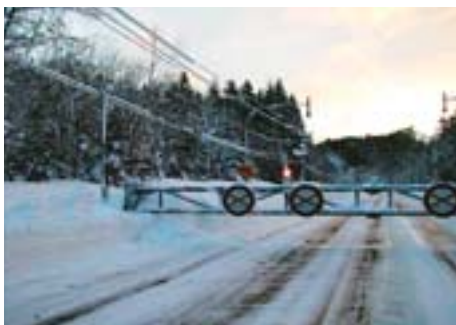
写真1 一般国道274号釧勝峠ゲート前 電線の着雪や樹木の冠雪は最近の新雪道路雪崩の危険信号でもある
