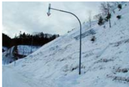
写真3 新しく積もった雪が古い雪の上を滑り落ちた新雪表層雪崩 (一般国道274号釧勝峠)
