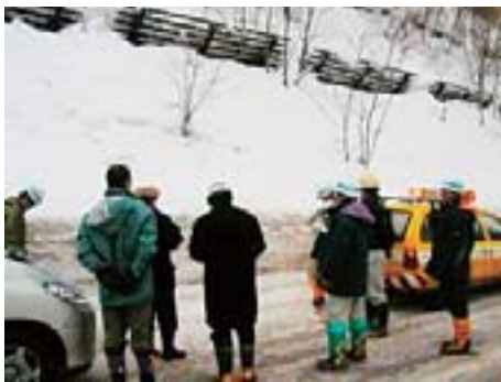
写真-7 雪崩現地調査では危険度の評価や対策について検討した （一般国道276号）
