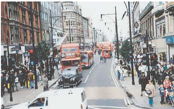
写真12 ロンドンオックスフォードストリートにおけるトランジットモール—トランジットモールは公共交通機関と歩行者のみの通行を許す街路で、ここではバス、タクシーと歩行者のみが通行を許される。手前の車はトランジットモールを横断する車で、横断は許される
