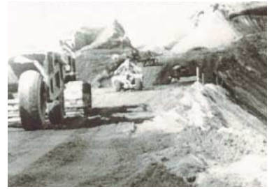
キャリオールスクレーパによる作業(2)
