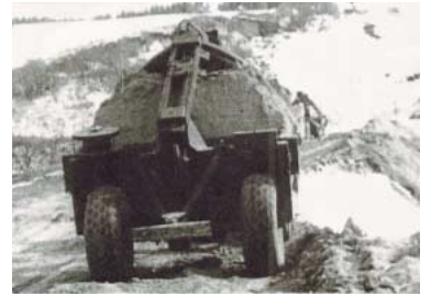
キャリオールスクレーパによる作業(1)
