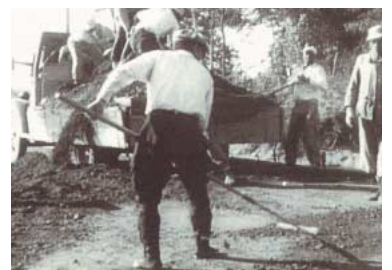
転圧コンクリートの舗設作業(2)
