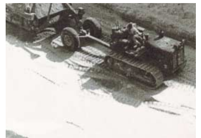
キャリオールスクレーパによる作業(3)
