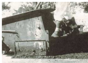
わが国初の機械による混合物の舗設作業
