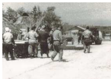
アスファルト・マカダムの施工状況
