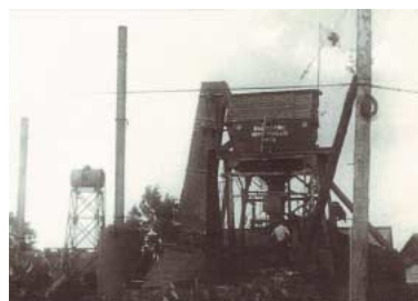
2工区のアスファルトプラント
