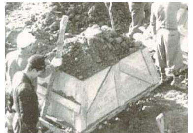
粘土質地帯の人力による切土・運搬作業
