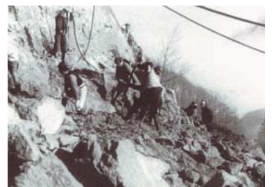
人力による法面仕上げ作業
