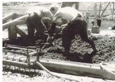
コンクリート舗装の舗設作業
