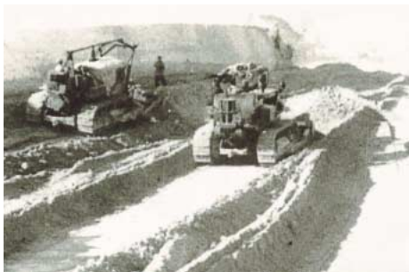
ブルドーザによる作業状況
