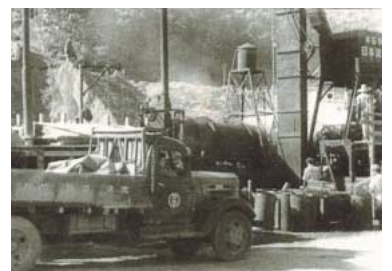
3工区のアスファルトプラント
