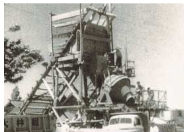
コンクリートプラント
