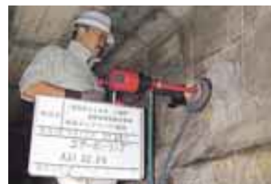
写真 - 1 コアボーリング
