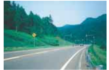
写真 - 4 遷移が進む緩傾斜のり面（国道230号）
