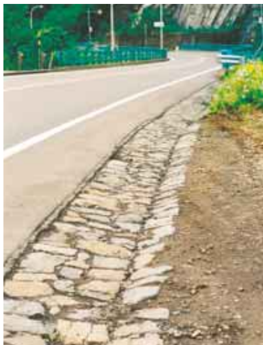
写真 - 6 現地発生材で造った皿型側溝（国道230号）
