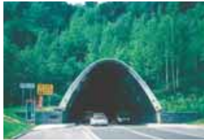
写真 - 3 定山溪トンネルのPCルーバー（国道230号）
