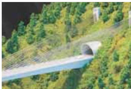
写真 - 9 谷を一切使わずに架設できるトンネルタワー式斜張橋
