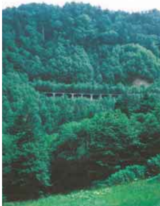
写真 - 5 自然に埋没した薄別回廊（国道230号）
