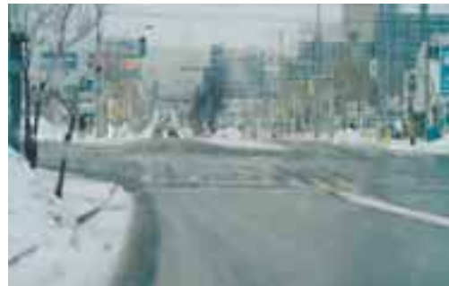
写真 1 札幌市内の道路には“悪しき北海道らしさ”がいっぱい／車線分離がない幅広の直進車線（手前側）の向こうに中央分離された道路の右折車線が対向。手前側道路の設計に配慮、工夫が求められる（札幌市厚別区）。
