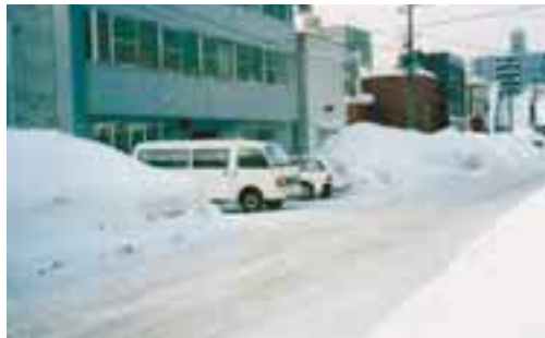
写真2 冬期は我が社の専用駐車場（札幌市北区）堆雪を考慮して設計された片側2車線道路も冬期には路肩や1車線が私的に専用されている例も多い。周辺環境や交通条件を総合的に考慮して、歩道、自転車道、および車道の横断形状を設計することが望まれる。
