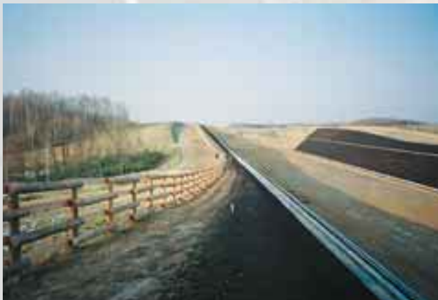
間伐材を使用した立入防止柵
