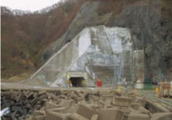
写真-3 狩場トンネル坑口保護盛土
