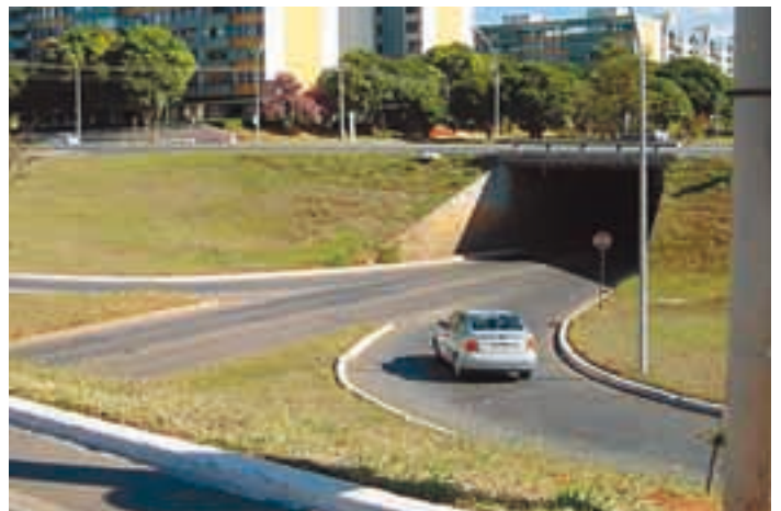
写真 - 7 エイショとアベニダとの接続部のインターチェンジ
