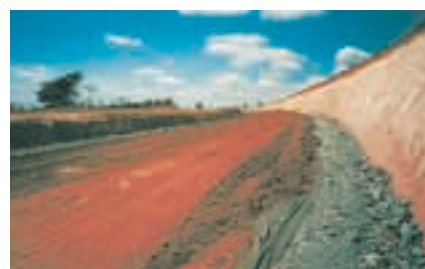
写真 - 13 地下排水工と防水シート工法
