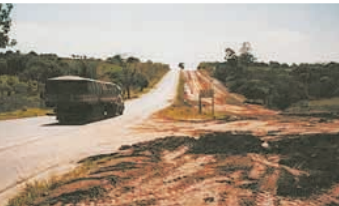
写真 - 10 国道の拡張工事現場
