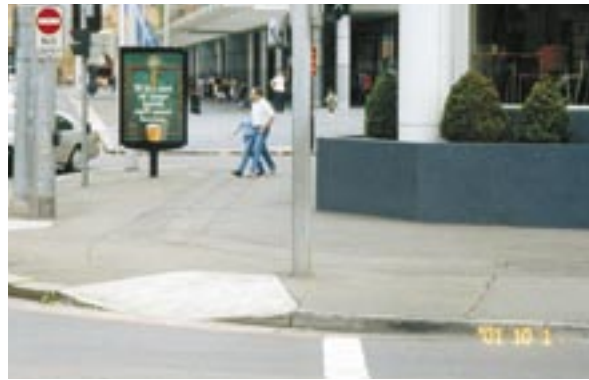
写真-5 歩道段差のすり付け
