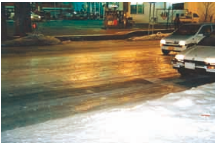
写真-3 雪による歩車道の段差と横断歩道付近のつるつる路面
