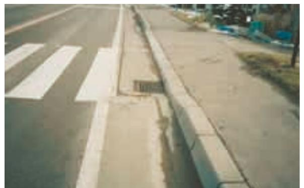
写真-3 端部段差が大きく、歩道幅員が狭小であるため横断勾配が急になった例
