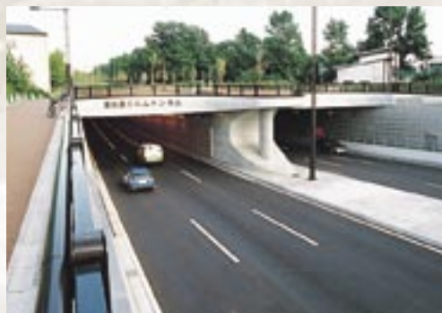
トンネル西側坑口
