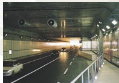
トンネル内車輛通行状況
