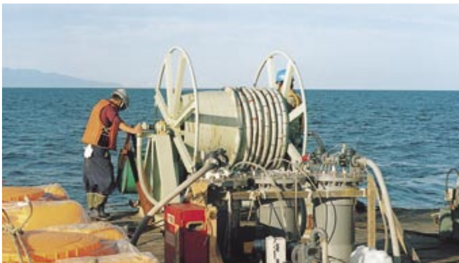
岩内湾深層水の簡易取水作業
