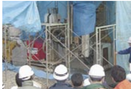
写真-4 WJ他公開試験状況(開発土木研究所)
