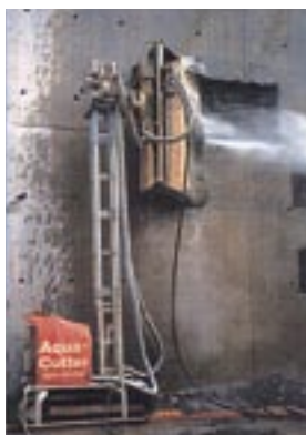
写真-1 WJによるコンクリート面はつり
