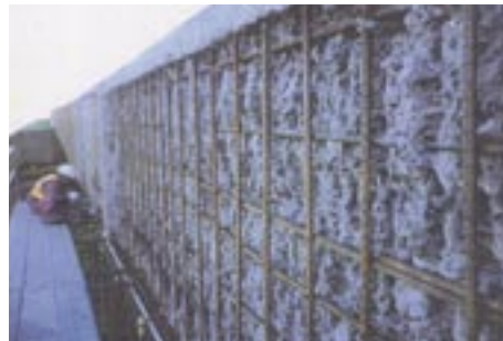
写真-3 WJによるはつり結果(北海道開発局)
