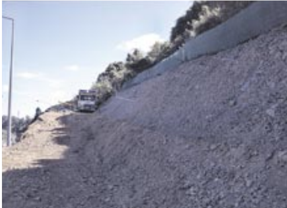
ロックボルトで補強しながらの切土
