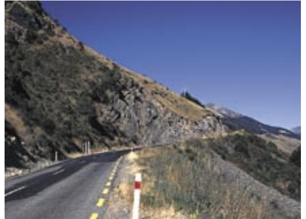
オチラ高架橋の現場へ向かう沿線は岩盤の切土のり面がいたるところに
