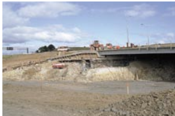
オークランド郊外の高速度道路の工事現場
