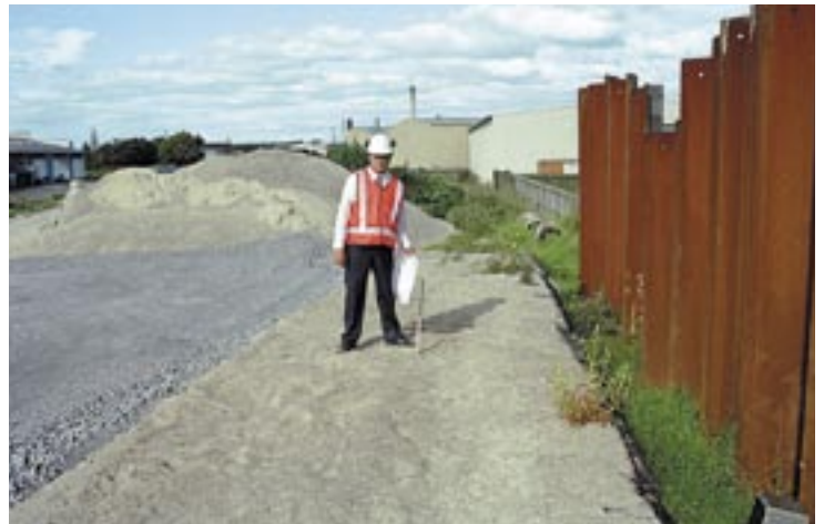
ジオテキスタイルを用いてのり勾配を立てた盛土 人物は、この盛土を設計したチェン博士
