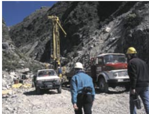
オチラ高架橋建設のためのボーリング調査
