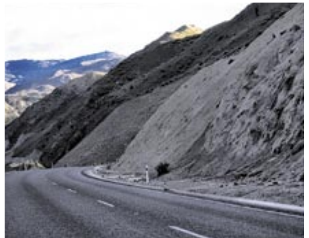
切土だけの国道のり面
