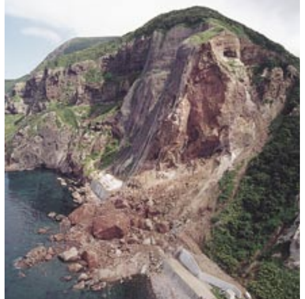
写真-2 第2白糸トンネル崩落事故
