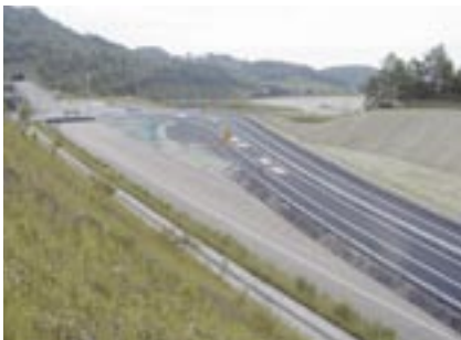
写真-4 虻田洞爺湖仮出入口
