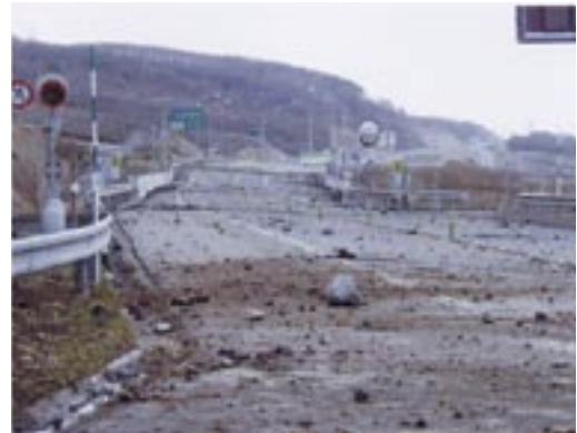
写真-5 洞爺トンネル東坑口付近の噴石
