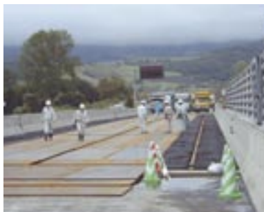
写真-9 泉の沢橋の載荷試験
