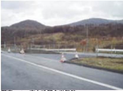
写真-3 東有珠緊急避難路
