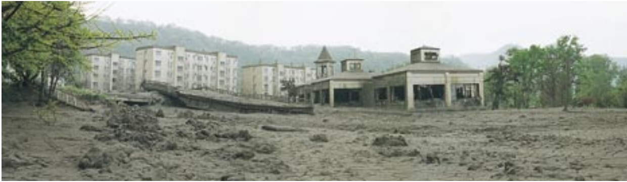
熱泥水により埋まった西山川流路工と流出した木の実橋桁（国道橋）（H12.5.31 撮影）（有珠山土砂災害対策専門家チーム撮影）
