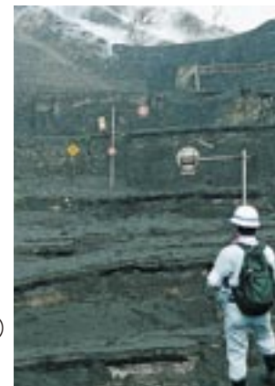
国道上の地溝帯（H12.7.12 撮影）（有珠山土砂災害対策専門家チーム撮影）
