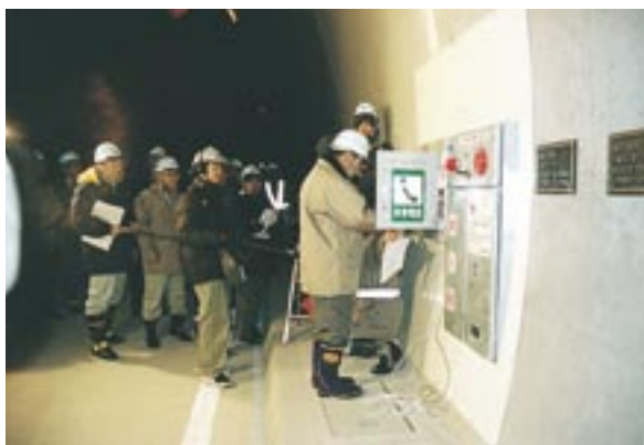
道路情報ネットワーク会議での現地説明(平成12年12月)
