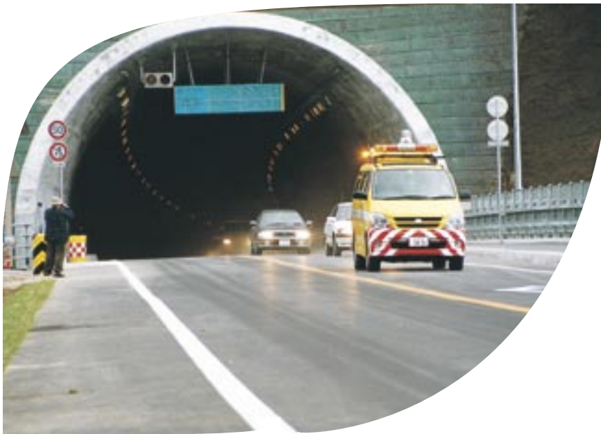
滝の澗トンネル開通(平成12年10月)
