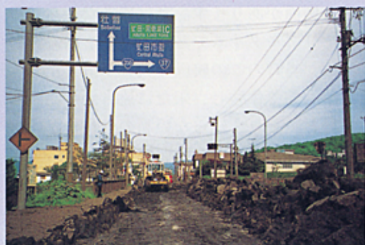
一般国道230号洞爺橋付近における降灰除去作業 (6月5日北海道開発局撮影)
