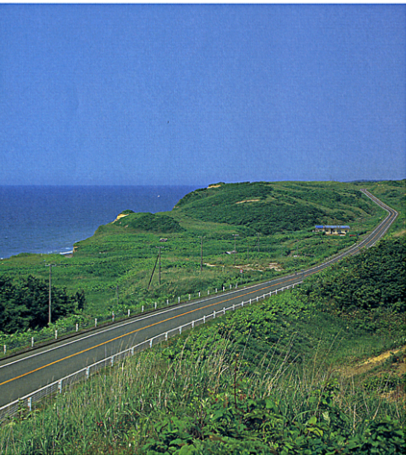
オロロンライン（国道232号／苫前町）
