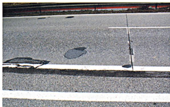
写真-1 痛みの激しいコンクリート舗装区間
