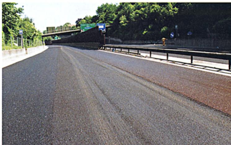
写真-3 サーフェイドレッシング（施工直後）
