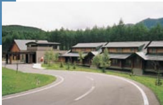
カラマツ大径木を使用したログホテル「ラーチ」宿泊棟
