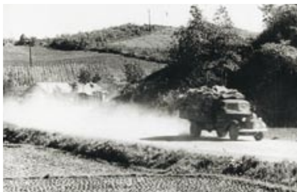
舗装される前の国道36号
