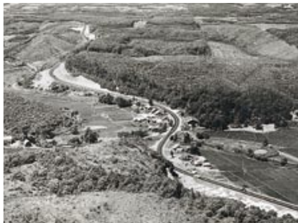
完成した国道36号島松沢付近
