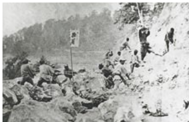
札幌本道の開削状況
