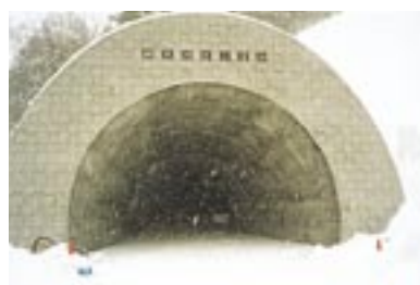
朝里峠トンネル
