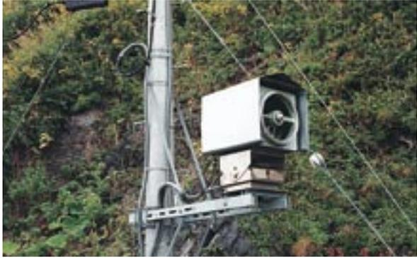
写真-3 旋回窓付監視カメラの設置状況
