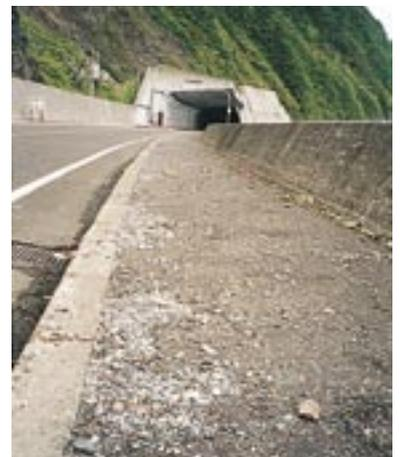
写真-2 越波により道路上に飛来した石
