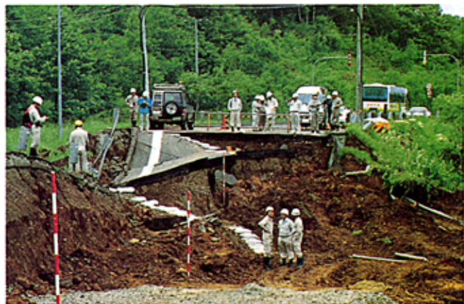
専門家の現地調査(国道5号 長万部町)
