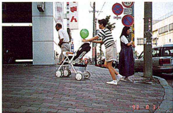
(写真-1) 横断歩道の急勾配すり付け
