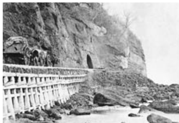
当時の海岸道路〈写真提供：北海道大学北方資料室〉
