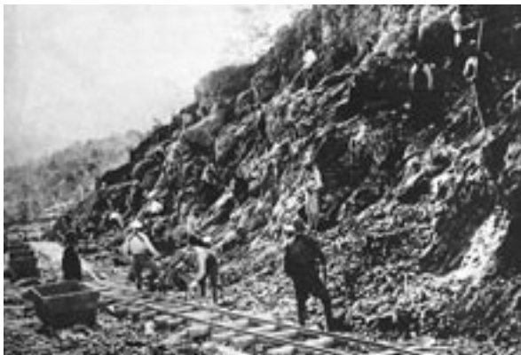
爆薬挿填穴作業 <写真提供：札幌国道写真帳より>
