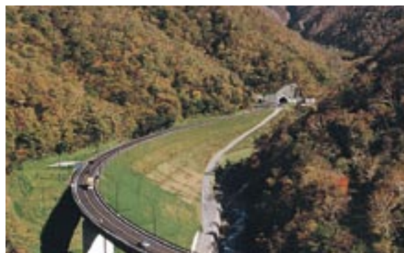
手前上杵臼大橋、後方野塚トンネル坑口
