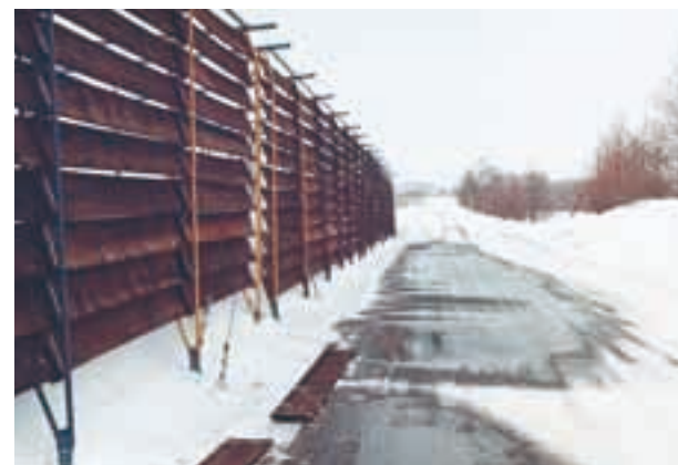
(写真-5) 最初の吹き払い柵(1967年、建設機械工作所)
