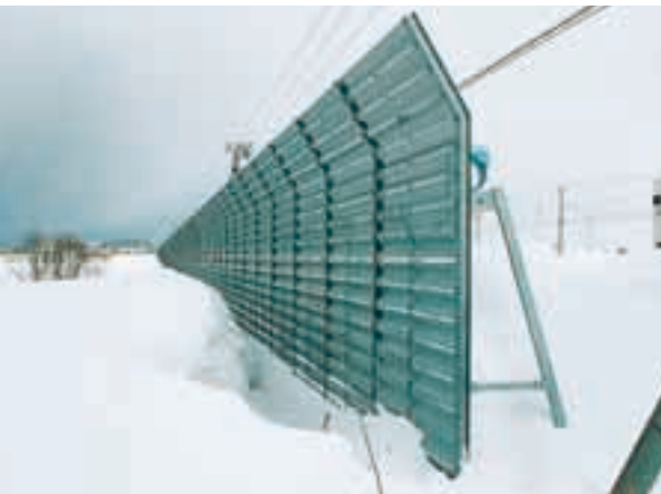
(写真 - 6) 最初の吹き止め柵 (1986年、国道230号石狩)
