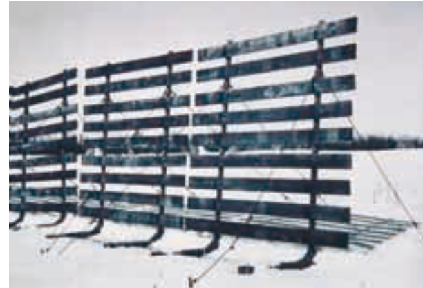
(写真-4) 古い型(木製、空隙率50%)の吹き止め柵 (1961年頃、石狩)
