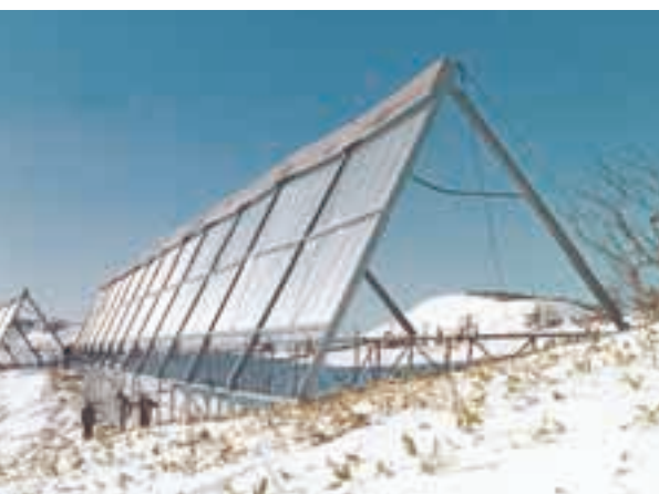
(写真 - 7) 雪庇防止柵 (1972年、国道243号美幌峠)
