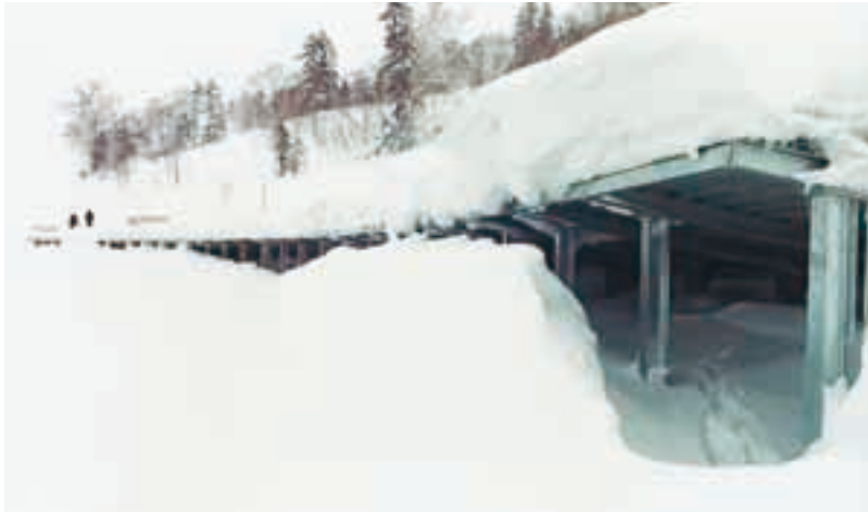
(写真 - 8) 最初の吹き上げ防止柵 (1976年、国道230中山峠)
