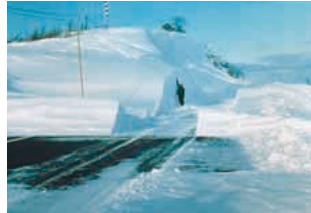
(写真 - 2) 吹きだまりに埋まった片切土 (1970年代初め、国道238号網走開発建設部)
