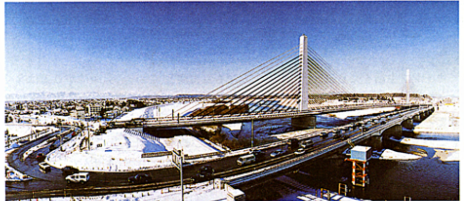
取り壊し直前の十勝大橋と建設中の新十勝大橋
