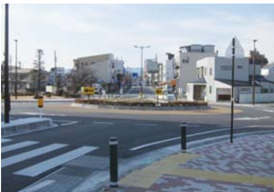
写真-1 国内第1号になった本格的なラウンドアバウト(長野県飯田市東和町)
