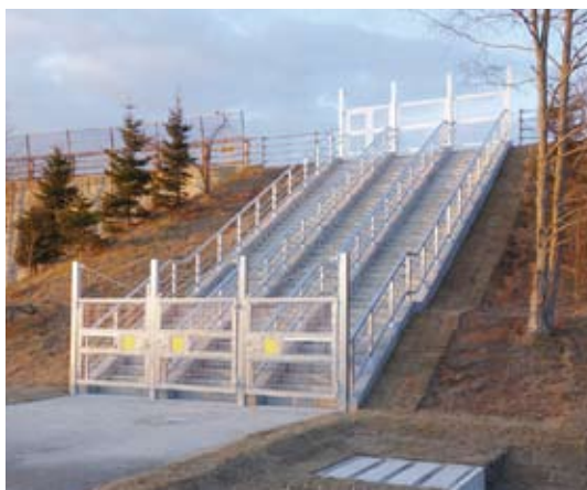
釧路市大楽毛に設置された避難階段(国道38号釧路新道) ・コンクリートブロック階段 ・通行幅1.5m×3列 ※緊急時以外は通行不可
