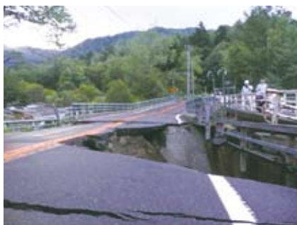
国道453号 河川による浸食・橋梁破損(奥漁川橋)、土石流
